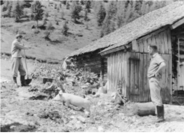
Sommer 1967: Ende des Wasserleitungsbaus durch Schluchten und Wald mit Anschluss zur Hütte unter Mithilfe von Menschen aus allen sozialen Schichten.
